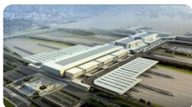
上海虹桥综合交通枢纽
